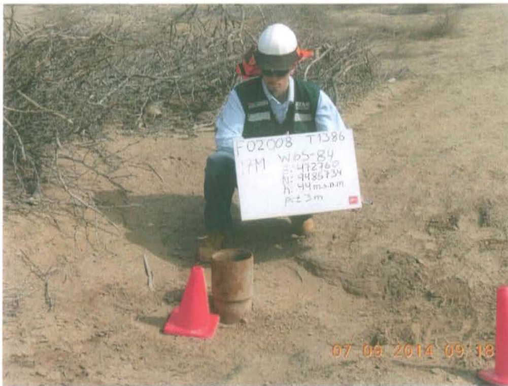
Fotografía N° 1. Identificación del pozo inactivo con código PERUPETRO T1386. Presenta casing abierto y cortado sobre el nivel de la superficie.
