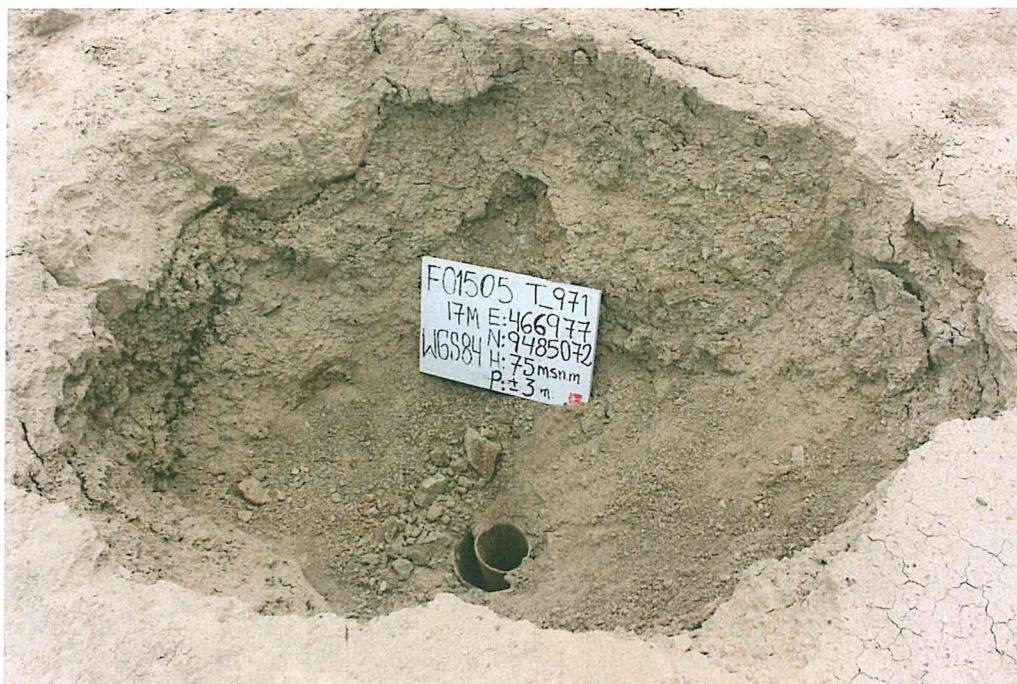
Fotografía N° 1. Vista del Pozo T_971, presenta casing de producción y de superficie abiertos dentro de un hoyo.
