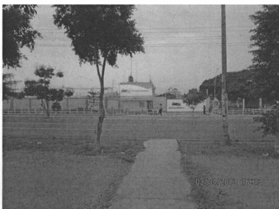
Foto 01: Instalaciones de ELECTRODUNAS S.A.A. en la ciudad de Ica
