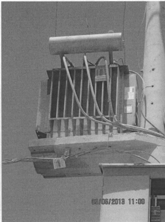
Foto 23: Equipo con rotulo rojo y con derrame de aceite
