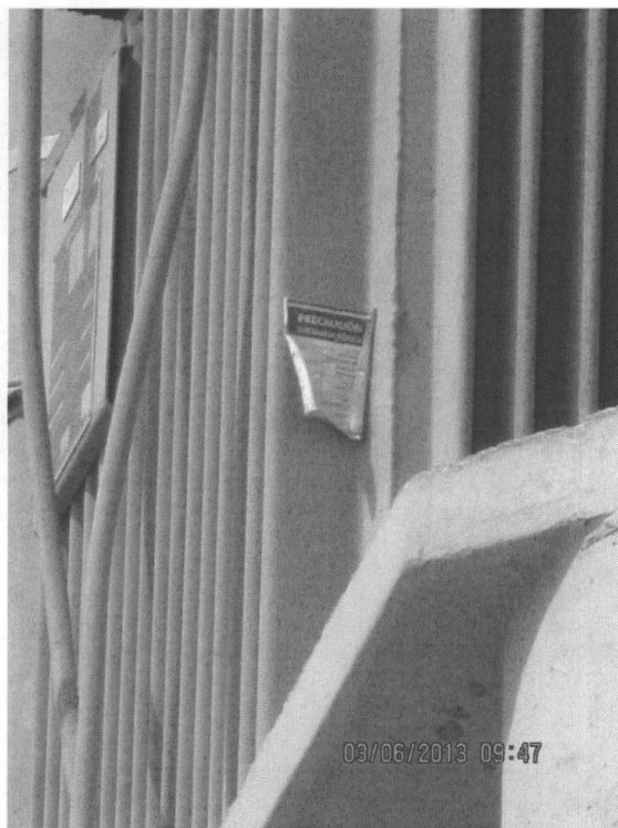
Foto 18: Equipo evaluado en Pisco con rotulo azul, < 50 ppm PCBs
