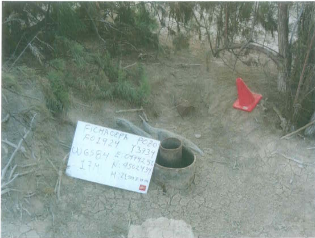
Fotografía N° 1. Pozo con código PERUPETRO T3734 y código Ficha OEFA F01924, se observa el casing y tubing corroído y abierto que se encuentra expuesto a 0,3 m al ambiente
