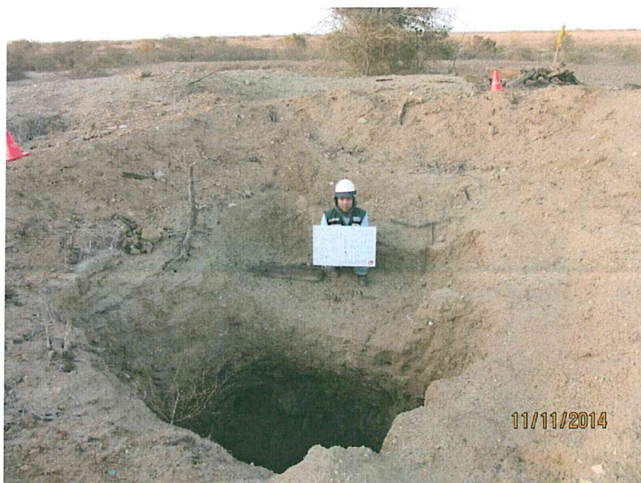
Fotografía N° 2. Se observa indicios de la existencia del pozo, como restos de madera .
