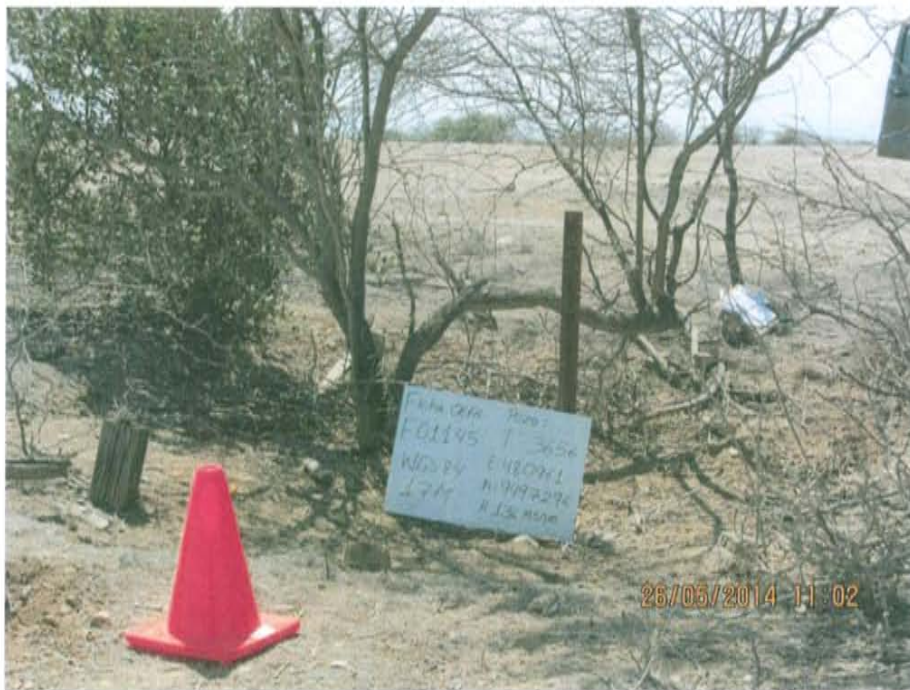
Fotografía N° 1. Pozo inactivo no se posee cabezal en su lugar hay un tubo de 2 pulgadas de aproximadamente 1,04 m de alto que se encuentra unido al pozo enterrado.
