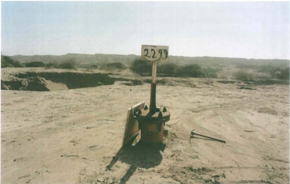
Fotografía N° 01.- Pozo con código PERUPETRO T2299 y con código Ficha OEFA F00584, se observa el casing corroído con una tubería lateral sin válvula de cierre por lo que se encuentra expuesto al ambiente; asimismo, se observa el cabezal compuesto por una brida reductora y una tubería soldada a una placa metálica.
