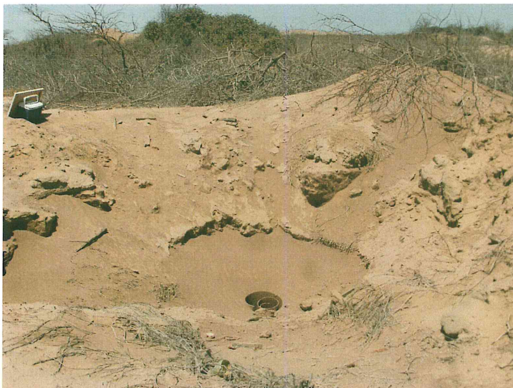
Fotografía N° 3. Pozo sin cabezal abierto al ambiente sin elementos de cierre que garantice su hermetismo, con fluido interno y emisión de gas.
