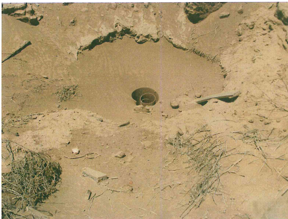
Fotografía N° 1. Pozo T1578 ubicado dentro de un hoyo de sección circular de 1,5m de profundidad con conductora y tubería de producción al ras del suelo.
