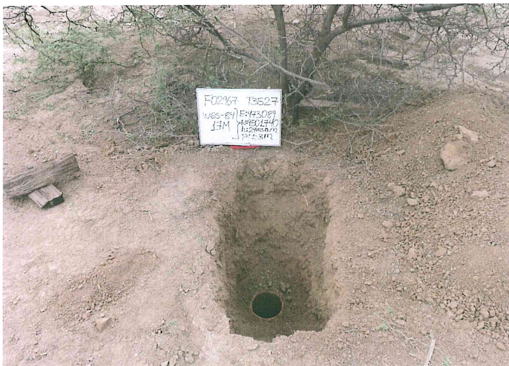
Fotografía N° 2. Se aprecia que el pozo T3527 no presenta elementos que garanticen el cierre hermético del pozo, el casing del pozo se encuentra cortado y abierto.
