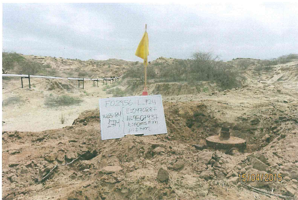
Fotografía N° 1. Ubicación del pozo inactivo, en el interior de un hoyo que fue excavado, no presenta terraplén habilitado.
