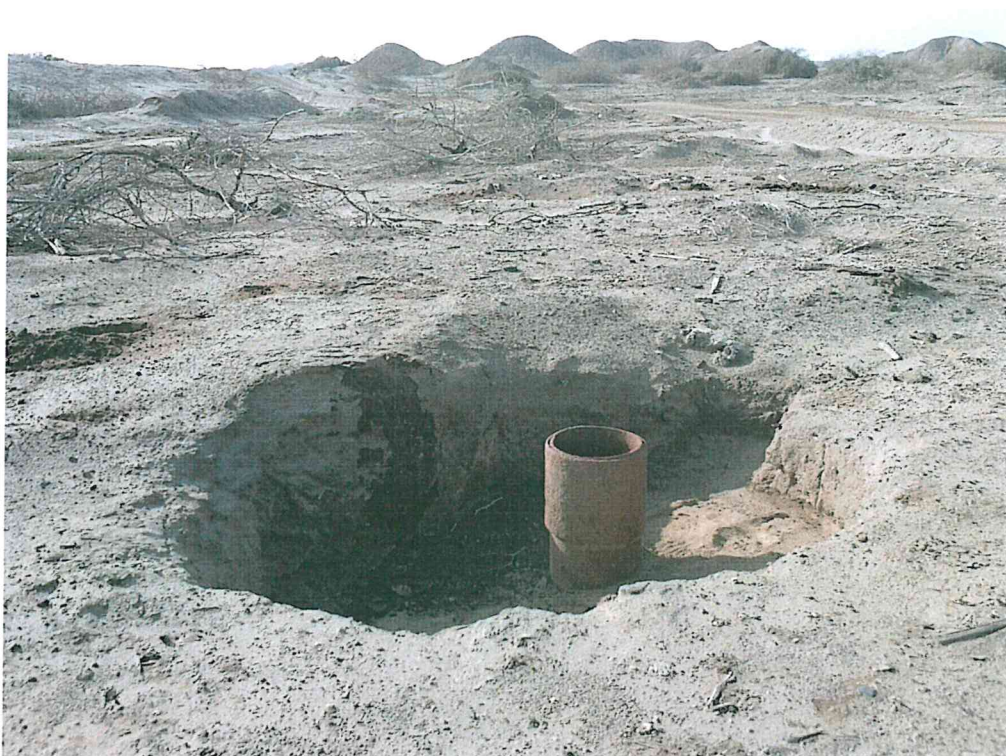
Fotografía N° 1. Pozo inactivo con código PERUPETRO T1704A donde se observa el casing abierto y expuesto al ambiente.
