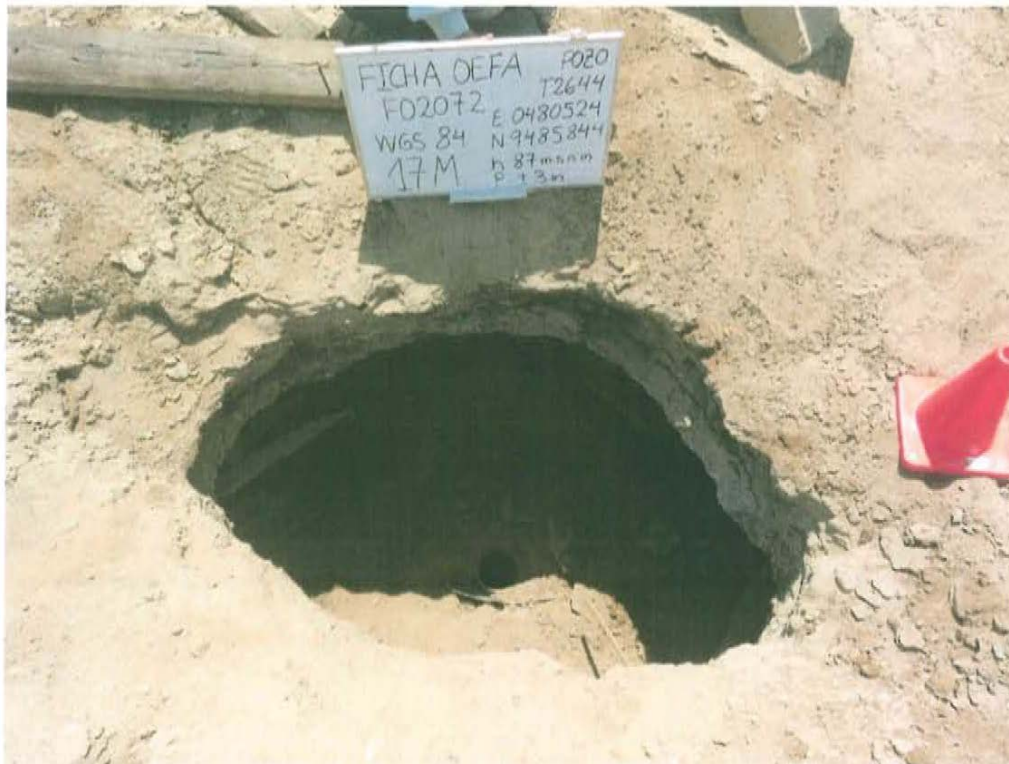
Fotografía N° 1. Pozo con código PERUPETRO T2644 inactivo mal abandonado, se observa casing con tubing en el interior de un hoyo de forma irregular a una profundidad aproximada de 1 m.
