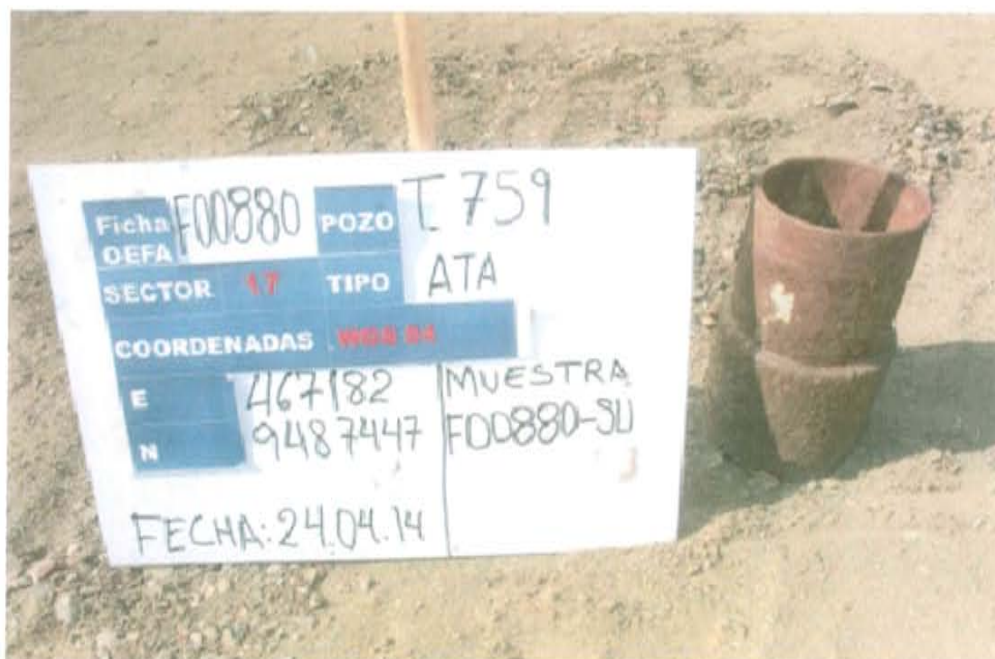
Fotografía N° 1. Vista de ubicación georeferencial donde se observa el pozo con el casing (Tubería de revestimiento) abierto en estado de deterioro.
