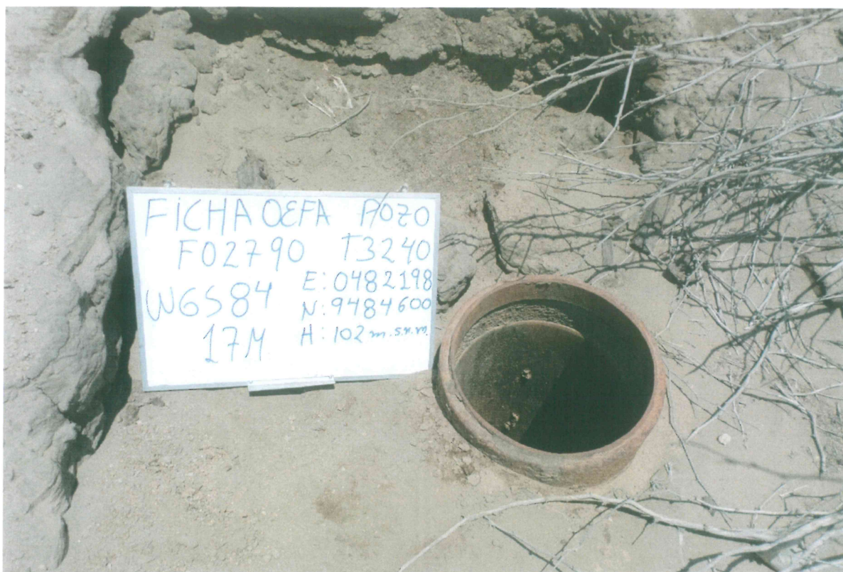
Fotografía N° 1. Pozo con código PERUPETRO T3240 y código Ficha OEFA F02790, se observa el casing corroído, sin cabezal o algún elemento de cierre por lo que se encuentra abierto al ambiente.
