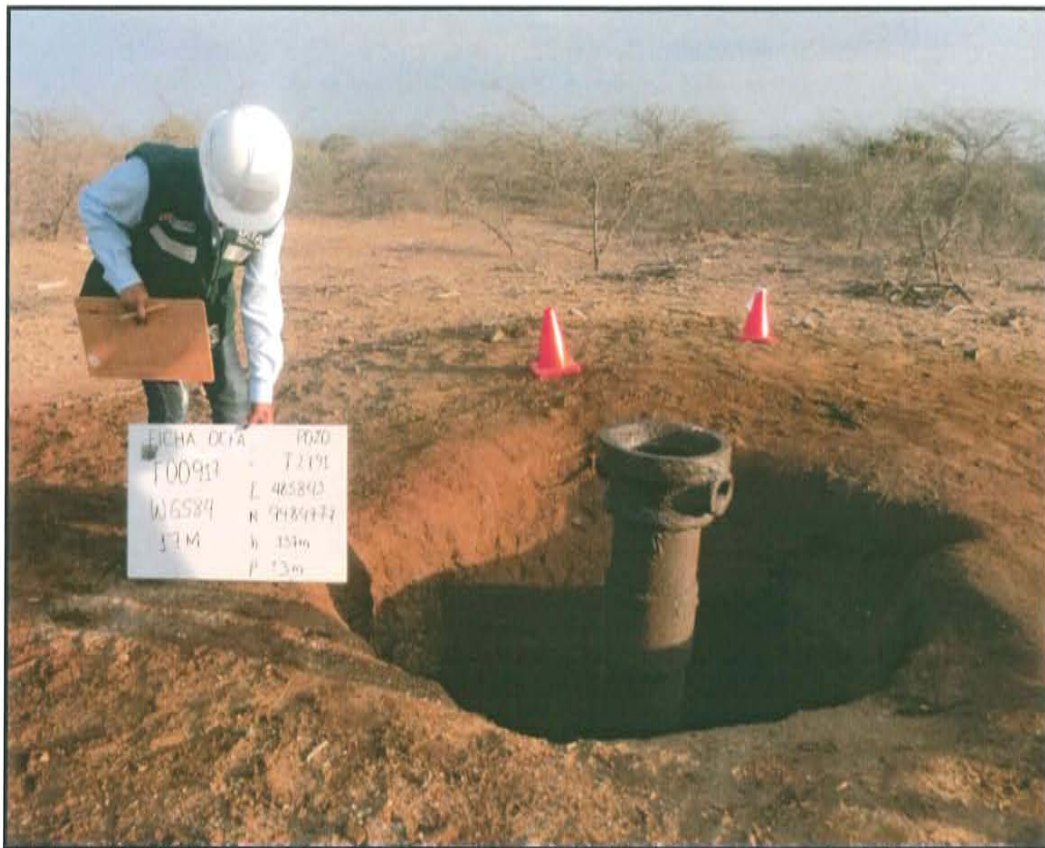
Fotografía N° 1. Pozo T2191 presenta casing de 12 plg que sobresale 1,5 m desde la base del hoyo de 1 m de profundidad.
