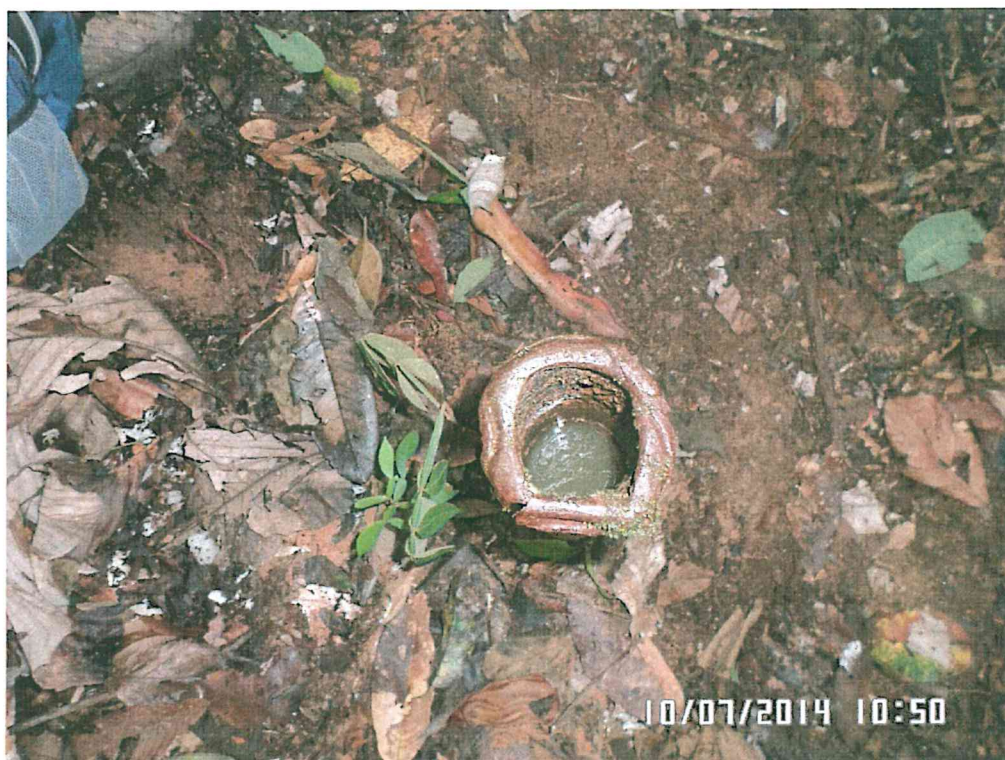
Fotografía N° 1. Vista del pozo inactivo con código de ficha OEFA F01469 (pozo 47__2), se observa el tubo abierto y deteriorado con agua en el interior del tubo producto de las precipitaciones pluviales.
