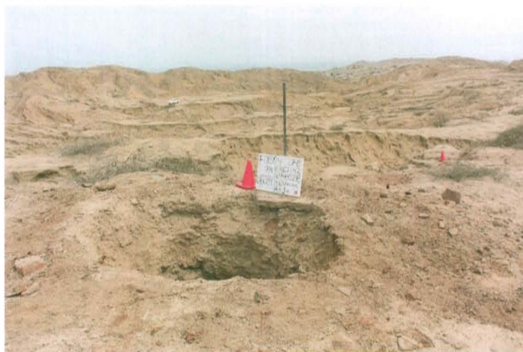
Fotografía N° 2. El pozo se encuentra dentro de un hoyo de aproximadamente 1,85 m de profundidad en una zona desértica.
