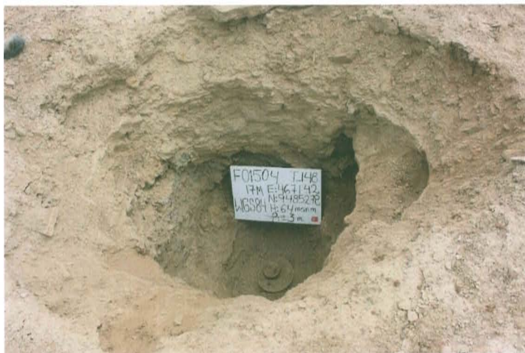
Fotografía N° 1. Pozo T_148, presenta casing de superficie y de producción cubierto con tierra.
