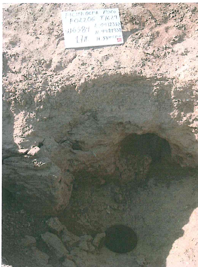
Fotografía N° 1. Pozo con código PERUPETRO T1629 y código Ficha OEFA F02206, se observa el casing del pozo expuesto a nivel de la superficie del suelo del hoyo, que no presenta cabezal o algún elemento de cierre por lo que se encuentra abierto al ambiente.
