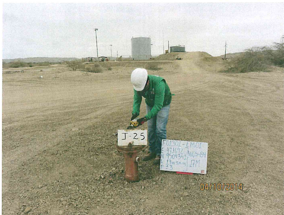
Fotografía N° 3. Medición de gases el 4 de octubre del 2014 se observa que el operador ha intervenido el pozo colocándole identificación, cabezal (compuesto por una brida con válvula de reducción abierta y válvulas laterales cerradas), así como también ha removido el suelo contaminado.
