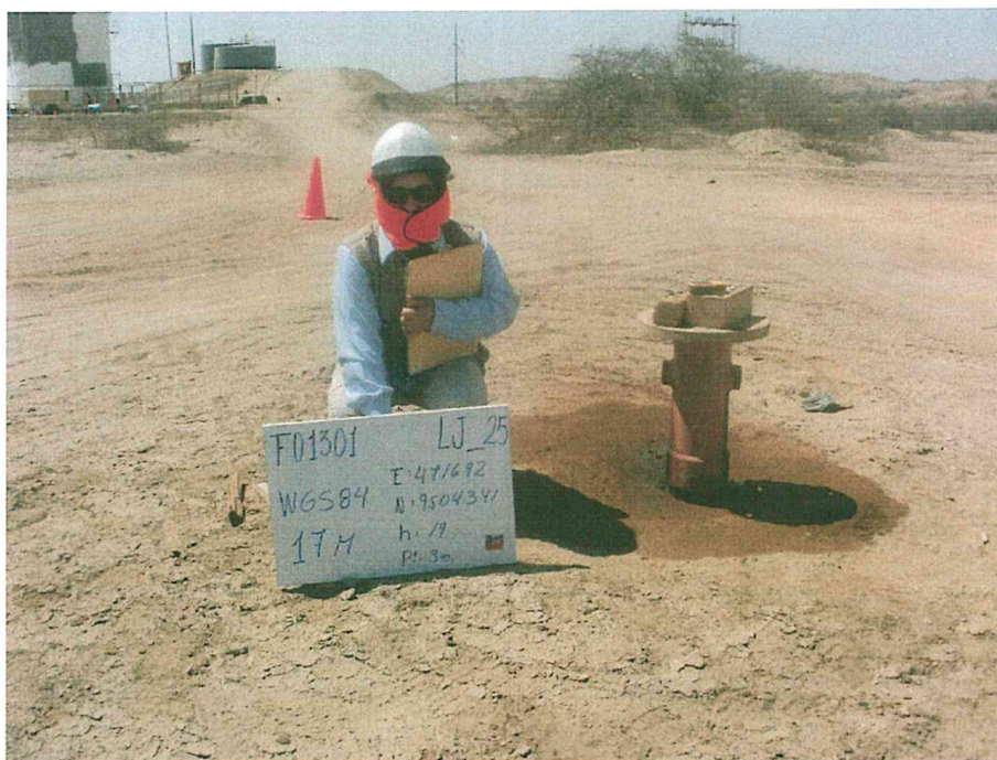
Fotografía N° 1. Pozo LJ_25 durante la primera evaluación, se observa tubería de revestimiento de 11 pulgadas de diámetro sin cabezal y con afloramiento de una mezcla de fluidos que gotean de la válvula de desfogue.
