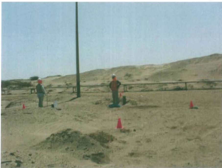
Fotografía N° 2. El pozo T1277 presenta terraplén cubierto por arena eólicas, a 6 m de la trocha carrozable, línea de transmisión secundaria y a 12 m de la tubería de conducción de crudo.
