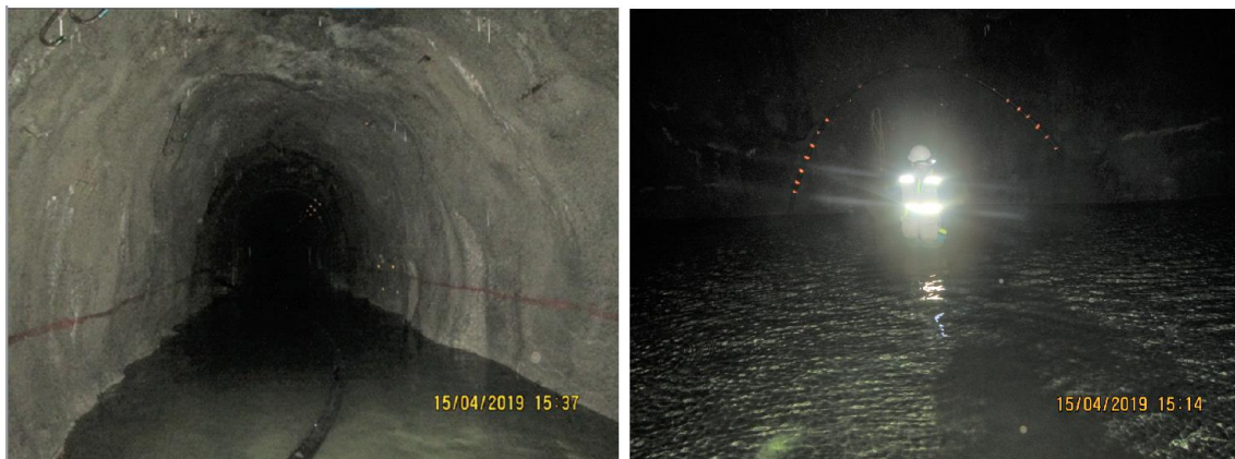
Figura 8.16. Fotografías del interior del túnel de aducción
