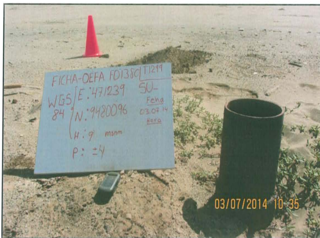
Fotografía N° 2. Pozo con código PERUPETRO T1299; con casing de 14 plg que emerge de la superficie del suelo por una altura de 0,4 m.
