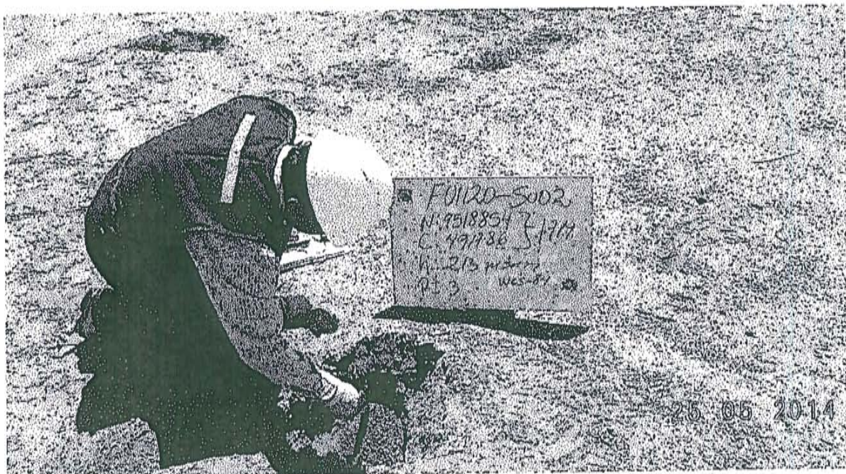
Fotografía N° 2. Toma de muestra de suelo en el punto FO1120-SU02, ubicado a 6,9 m aproximadamente del Pozo 5969 (NN12-II).
