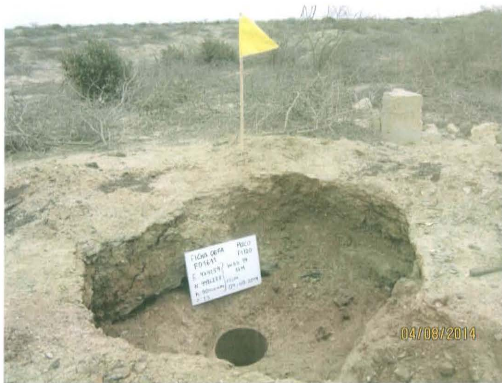
Fotografía N° 1. El Pozo T1720 se ubica en un hoyo de aproximadamente 2,1 m x 2,2 m x 1 m de profundidad.
