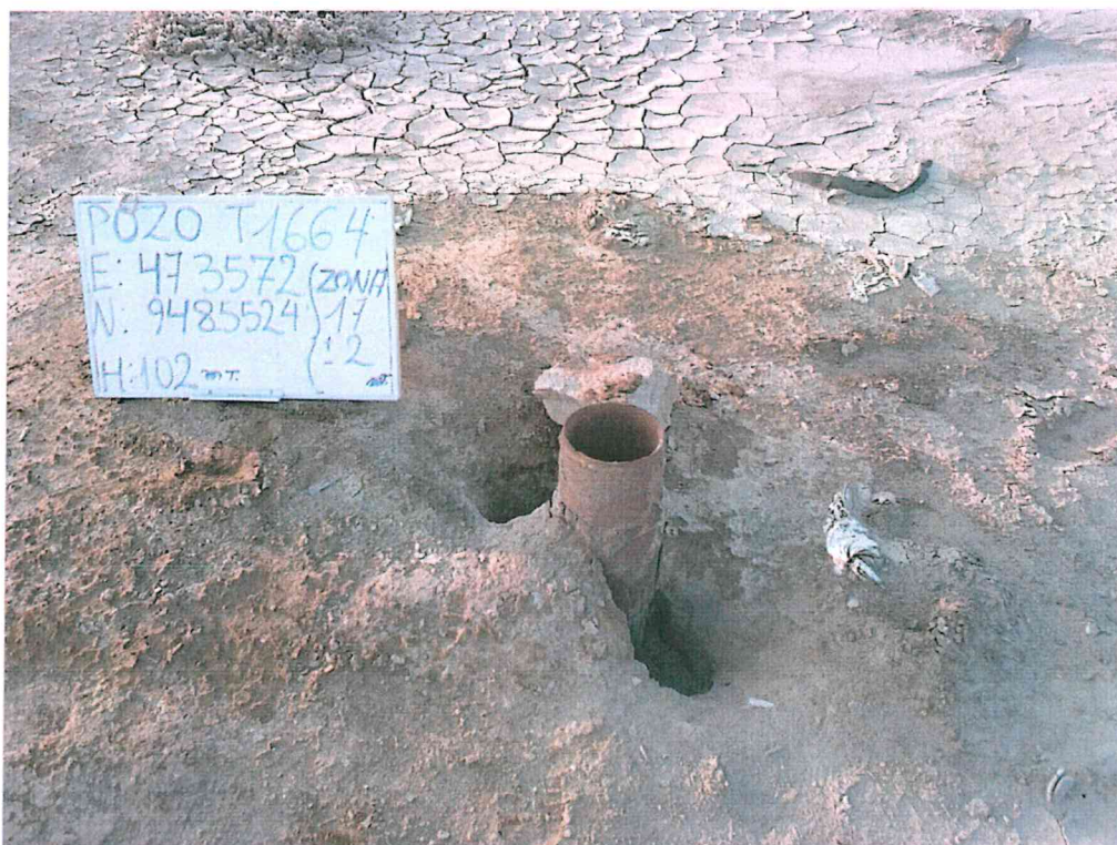
Fotografía N° 1. Vista pozo T1664 ubicado en una planicie, se observa el casing abierto al ambiente.
