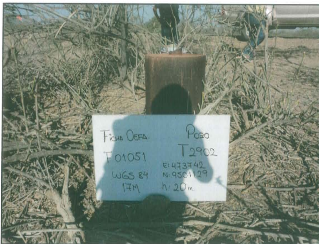
Fotografía N° 1. Pozo que cuenta con tapa soldada y tubo de salida de 2 plg en la parte superior, que emerge a una altura de 0,9 m desde la superficie del suelo.
