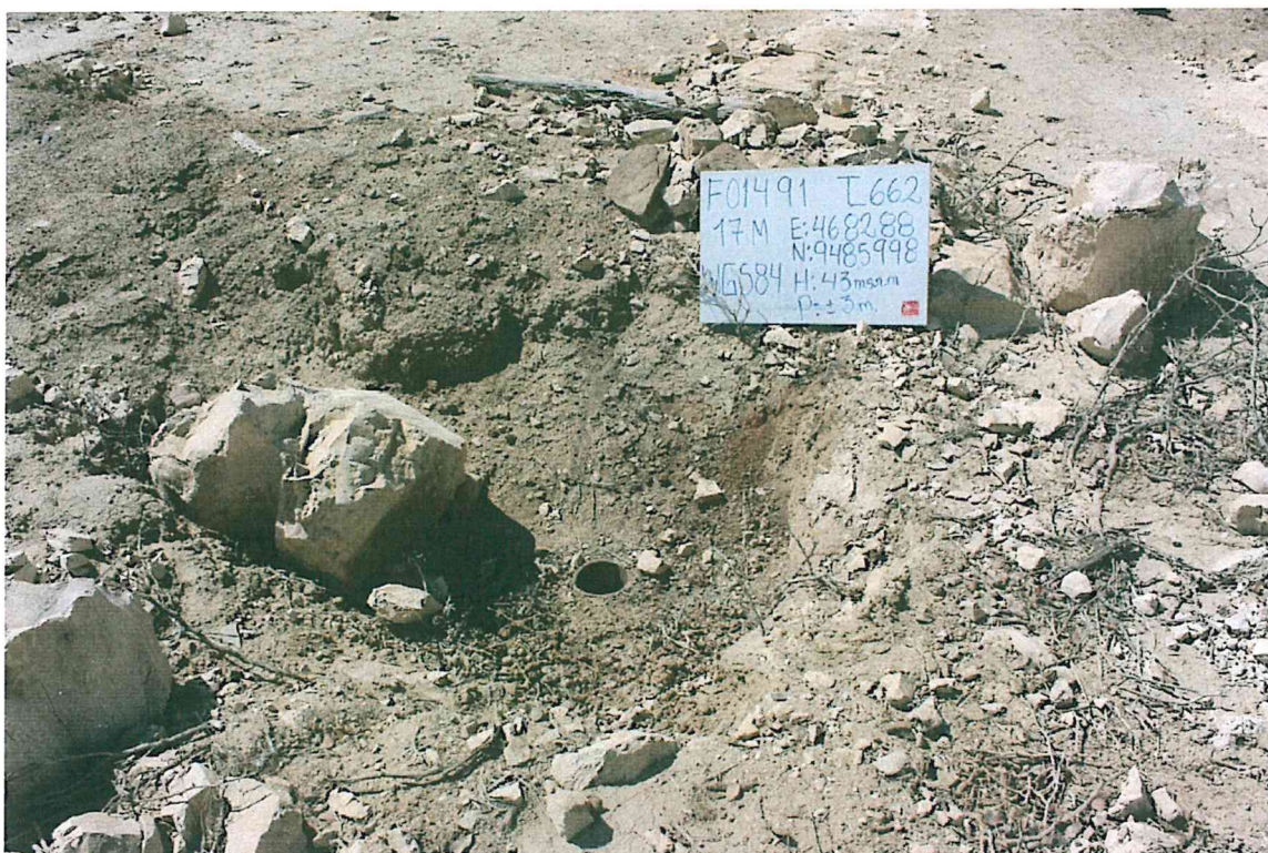
Fotografía N° 1. Pozo con código PERUPETRO T_662 y código Ficha OEFA F01491, se observa pozo dentro de un hoyo con el casing sin cabezal o algún elemento de cierre por lo que se encuentra abierto al ambiente.
