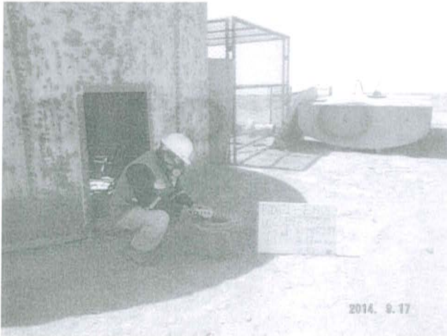
Fotografía N° 1. Medición en el punto F00671-EM01, ubicado en la fuente de emisión en boca del Pozo T1812.
