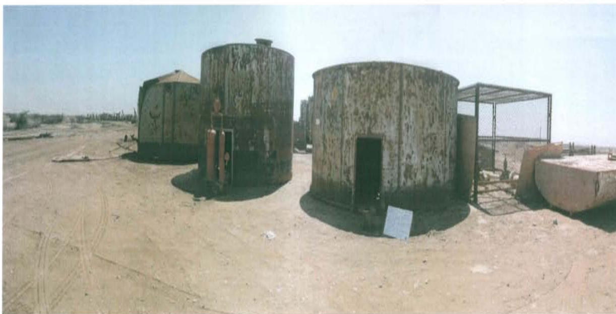
Fotografía N° 2. Ubicación del pozo T1812 en el patio de la batería 130.
