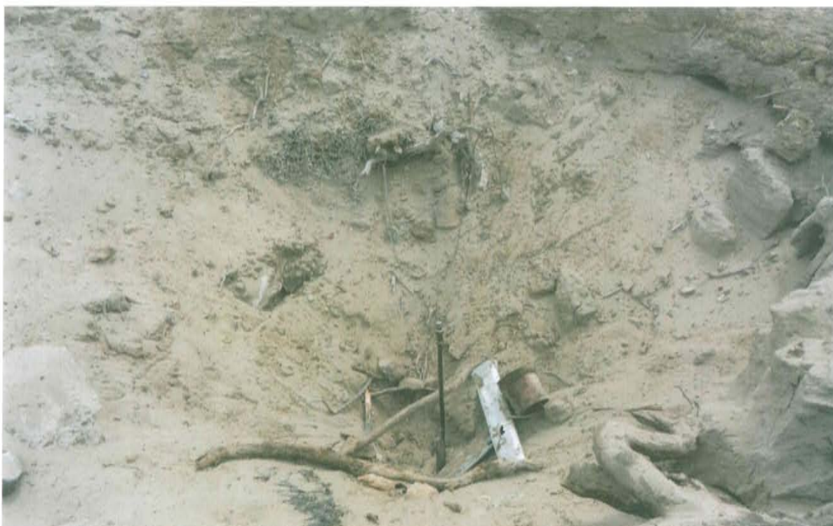
Fotografía N° 01.- Pozo con código PERUPETRO T1807 con Ficha OEFA F01214, se observa el casing a nivel de la superficie del suelo, ubicado dentro de un hoyo y no cuenta con cabezal o alguna válvula de cierre por lo que se encuentra abierto al ambiente
