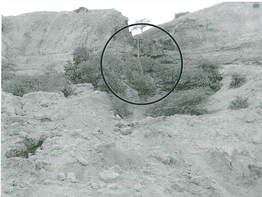
Fotografía 9: Caída de aguas residuales industriales de la zona industrial II – bahía Paita
