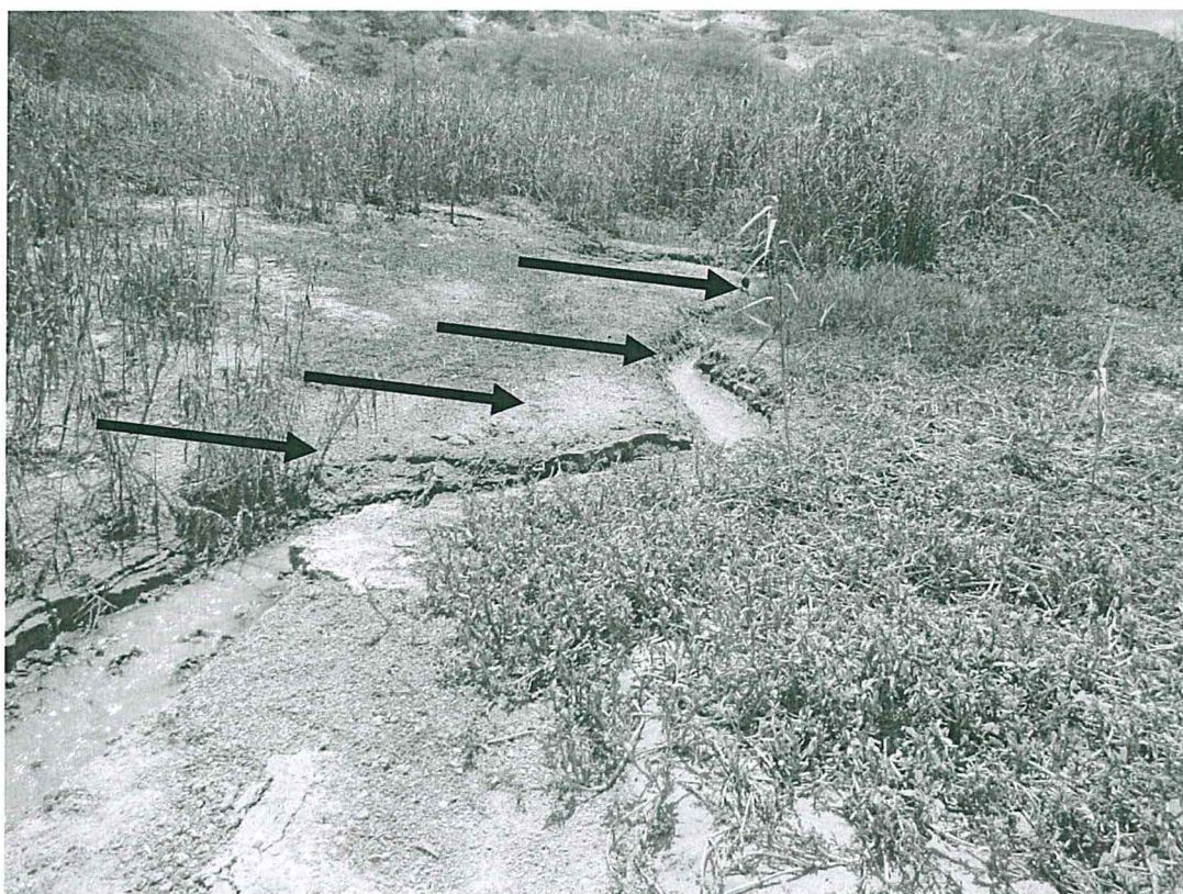
Fotografía 10: Canal construido para el flujo de aguas residuales industriales de la zona industrial II – bahía Paita
