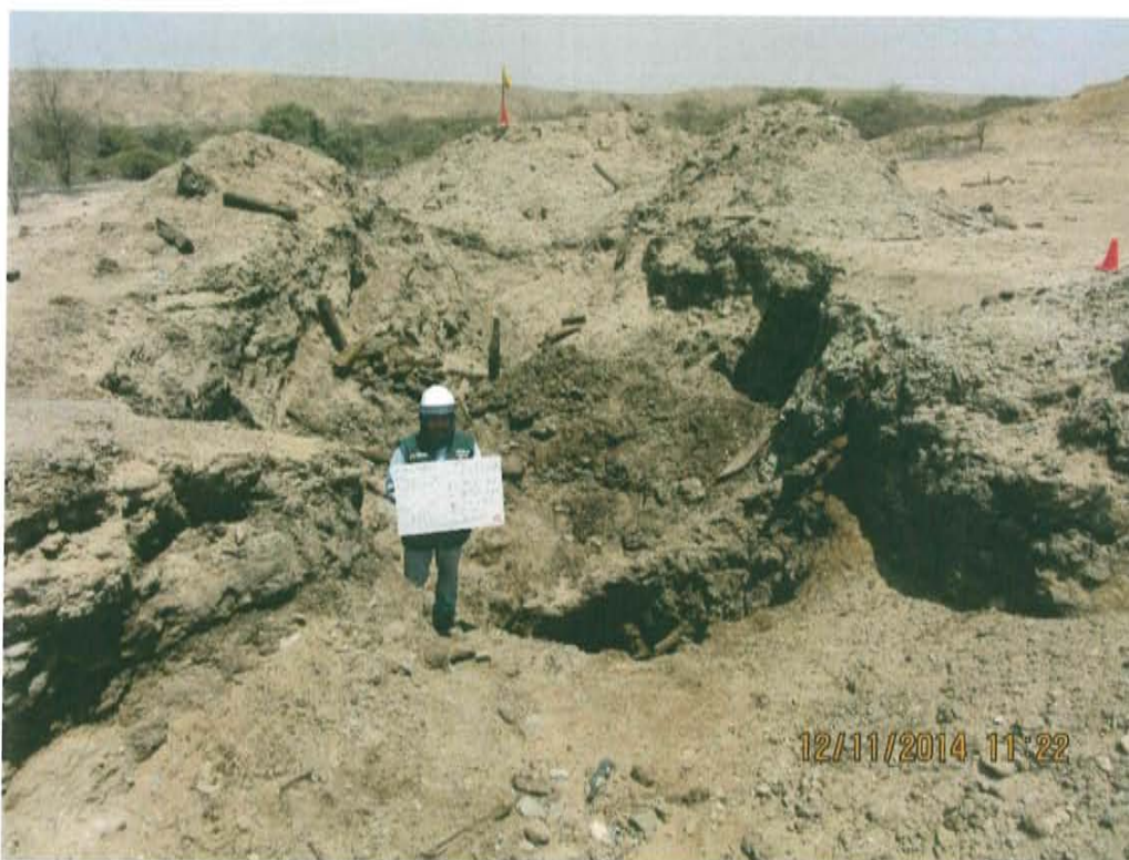
Fotografía N° 2. Vista panorámica del área evaluada del Pozo T1714A, donde se observa que el terreno ha sido excavada para la posible remoción del casing.
