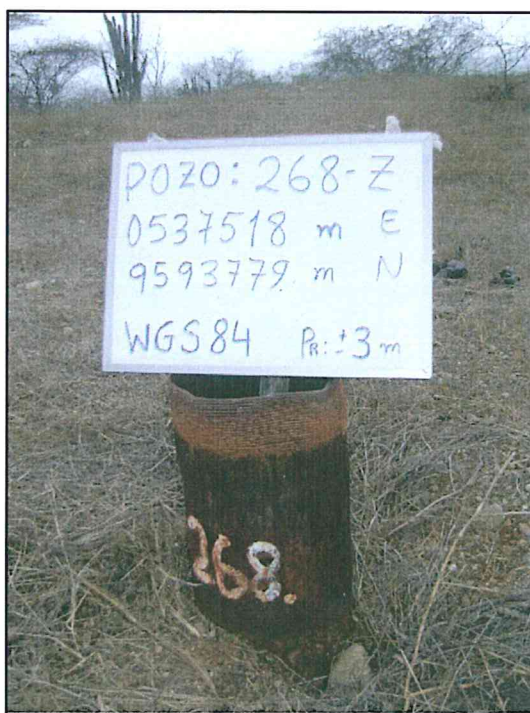
Fotografía N° 1. Se observa el Pozo 268-Z con casing abierto y expuesto al ambiente.
