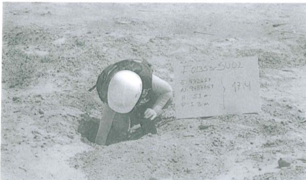
Fotografía N° 2. Toma de muestra en el punto F01353-SU02, ubicado a 5,8 m de distancia del casing del pozo T 1804 a una profundidad de 0,45 m de la superficie del suelo.
