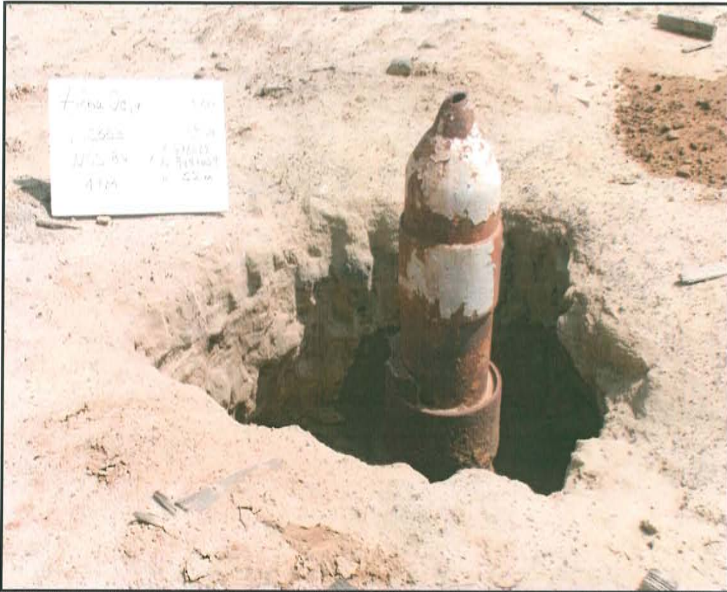
Fotografía N° 1. Cabezal de pozo T 1804 compuesto por tubería de reducción unida al casing de 16 pulg que emerge una altura de 1,9 m que sobresale desde la base del hoyo de 1,1 m de profundidad.
