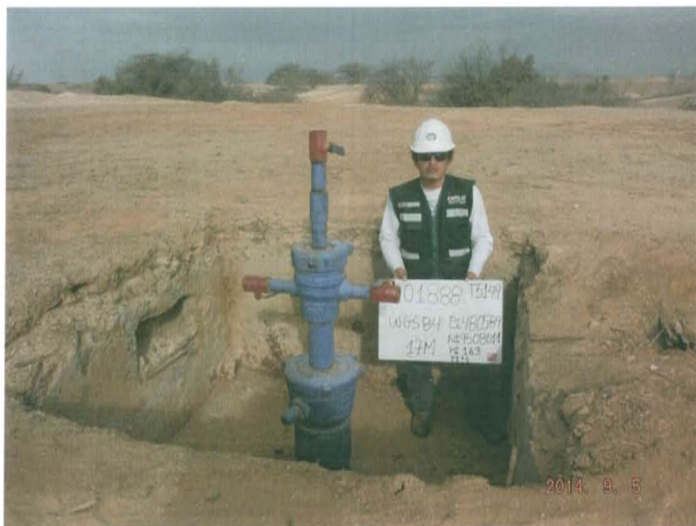
Fotografía N° 1. Pozo inactivo se encuentra dentro de una cantina deteriorada de 1,10 m de profundidad. El pozo emerge 1,7 m del nivel de suelo en la cantina y está compuesto por un arreglo de tuberías, bridas y válvulas (concéntricas y laterales)
