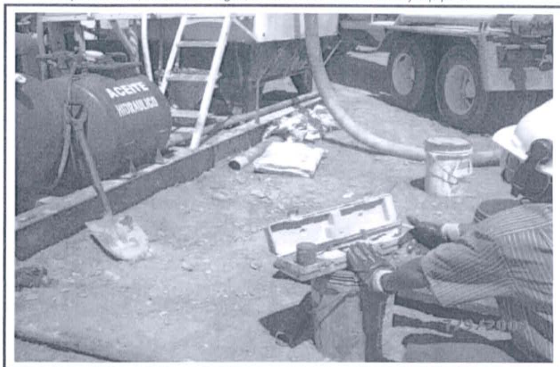
Foto 6. Midiendo densidad de lechada de cemento durante el tercer tapón.
