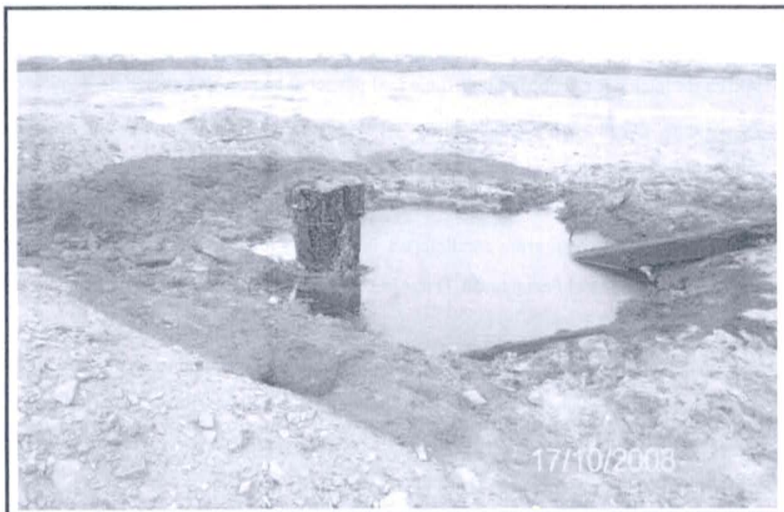
Foto 1. Estado inicial de la ubicación del pozo, situación de la cantina y terraplén, durante el año 2008.
