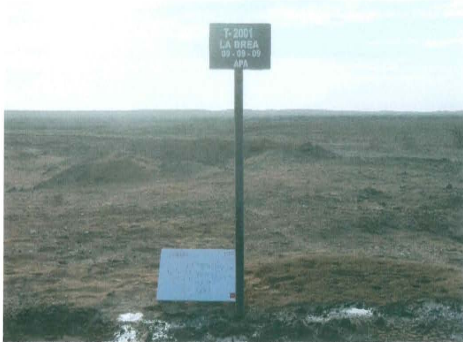
Fotografía N° 1. Vista del pozo mal abandonado donde se observa la varilla con el letrero de identificación y fluido proveniente del pozo en la superficie del suelo.
