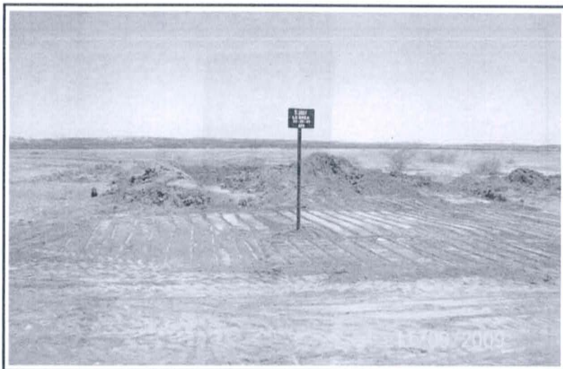
Foto 8. Vista panorámica del Pozo T 2001 La Brea concluido, mostrando terraplén limpio, tubo de 2 mts y letrero según reglamento.
