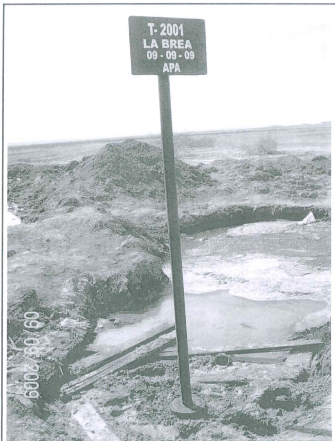
Foto 7. Después de la cementación, soldó plancha que tapa el pozo y colocó encima tubo de 2.00 m de altura con letrero.
