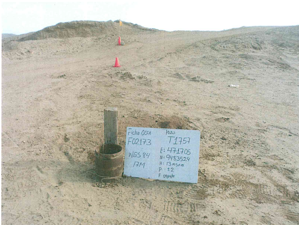
Fotografía N° 1. Se observa casing corroído de aproximadamente 8 plg de diámetro y se encuentra abierto al ambiente.
