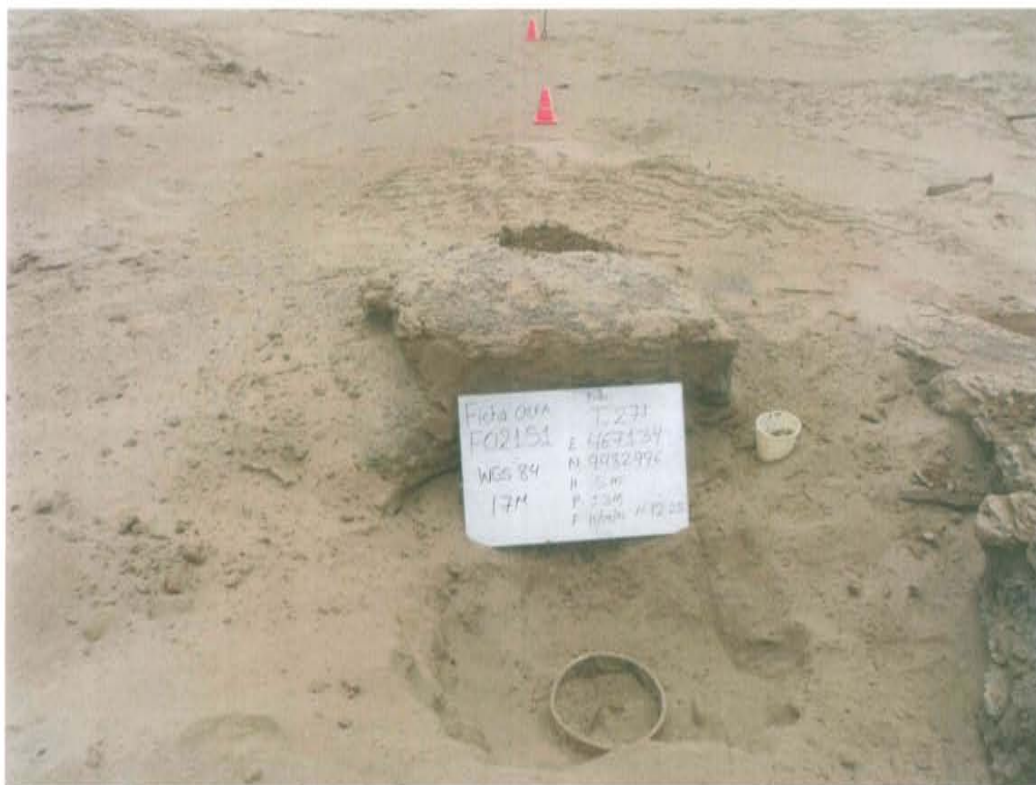
Fotografía N° 1. Se observa casing a nivel de superficie del suelo conteniendo arena en su interior que posiblemente no garantiza el cierre hermético del pozo.
