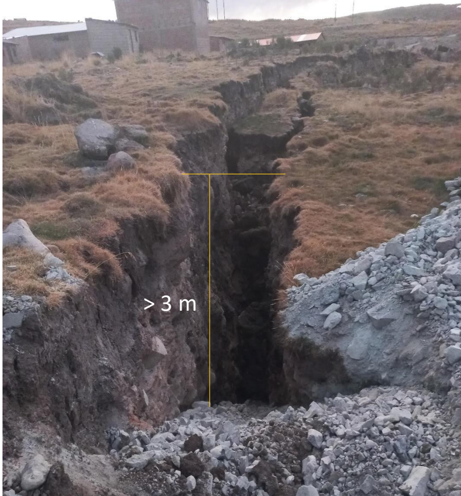
Fotografía N° 07. Deslizamiento activo ubicada al sur del Tajo Sur.
