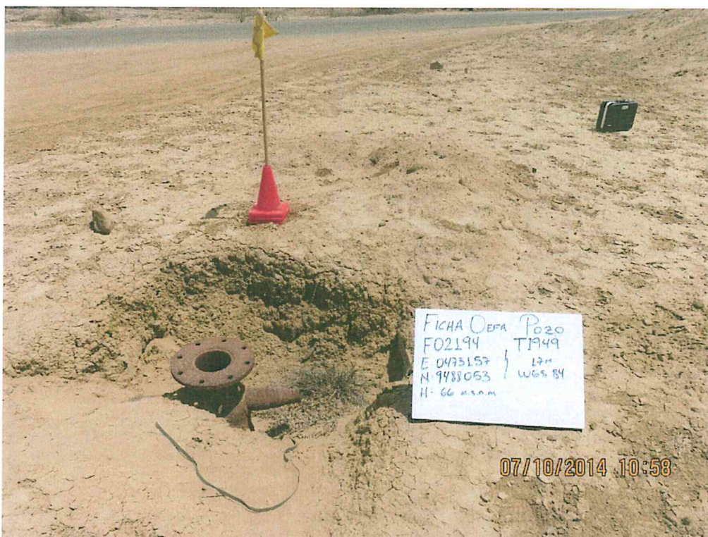
Fotografía N° 1. Vista pozo T1949 ubicado en un relieve plano cerca de vía asfaltada, se observa el casing abierto al ambiente.
