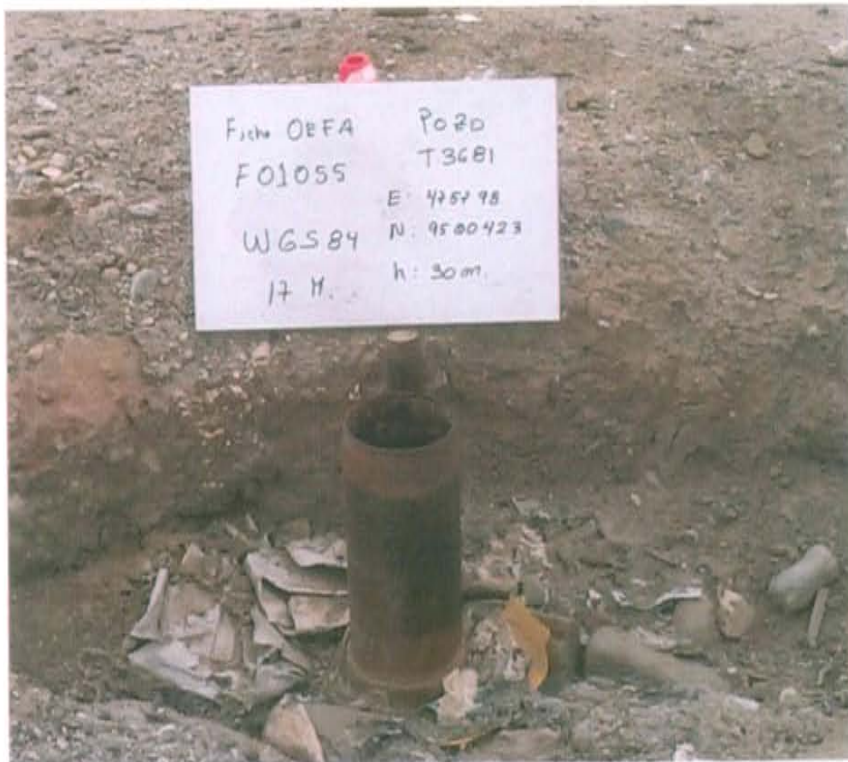
Fotografía N° 1. Pozo inactivo con código PERUPETRO T3681. Se observa casing a nivel de superficie, no presenta cabezal.
