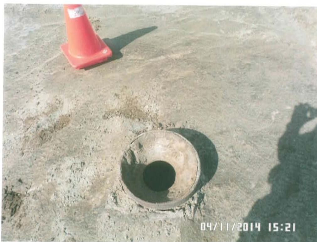
Fotografía N° 1. Vista pozo T_986, se observa el casing abierto al ambiente y rodeado de suelo contaminado por hidrocarburos.
