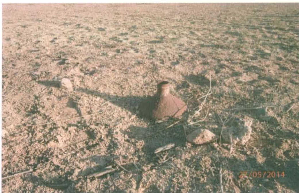
Fotografía N° 1. Vista de ubicación del pozo donde se observa el pozo con el casing y brida en estado de deterioro y abierto.
