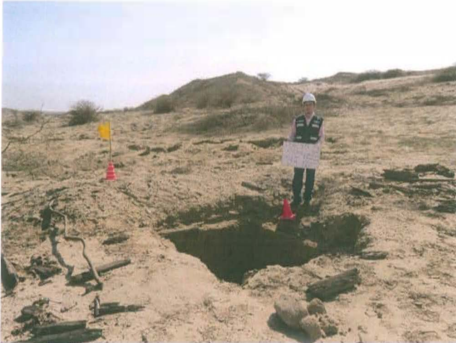
Fotografía N° 1. Se observa pozo inactivo expuesto al ambiente, en el interior de una cantina deteriorada.
