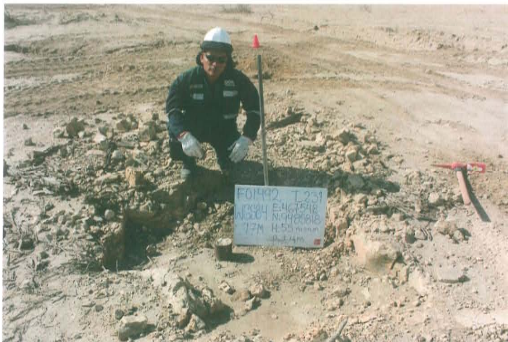
Fotografía N° 1. Pozo T_231, presenta casing cortado, abierto y lleno de tierra.
