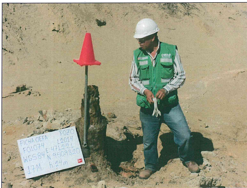
Fotografía N° 1. Vista del Pozo L2014, casing corroído de 12 plg de diámetro sin elementos de cierre (válvulas), por lo que el pozo se encuentra abierto y expuesto al ambiente.
