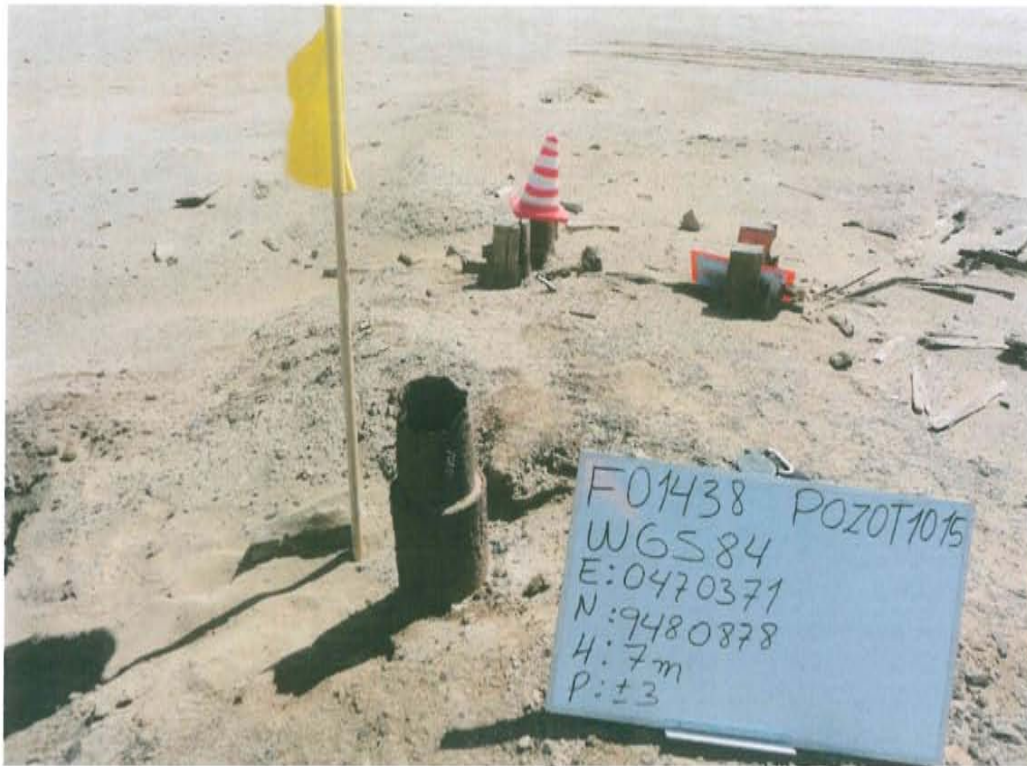
Fotografía N° 1. Pozo mal abandonado perteneciente a la ficha F01438 en el que visualiza una zona con presencia de hidrocarburo alrededor del pozo.
