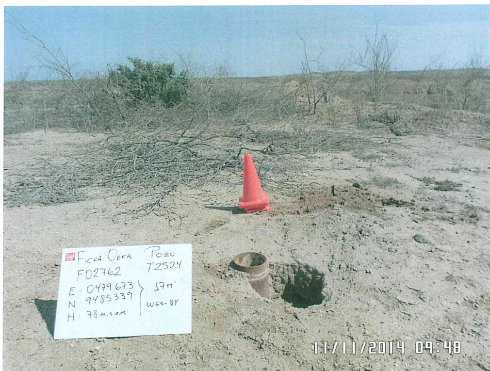
Fotografía N° 1. Vista pozo T2524 ubicado en un relieve plano, se observa el casing abierto al ambiente.
