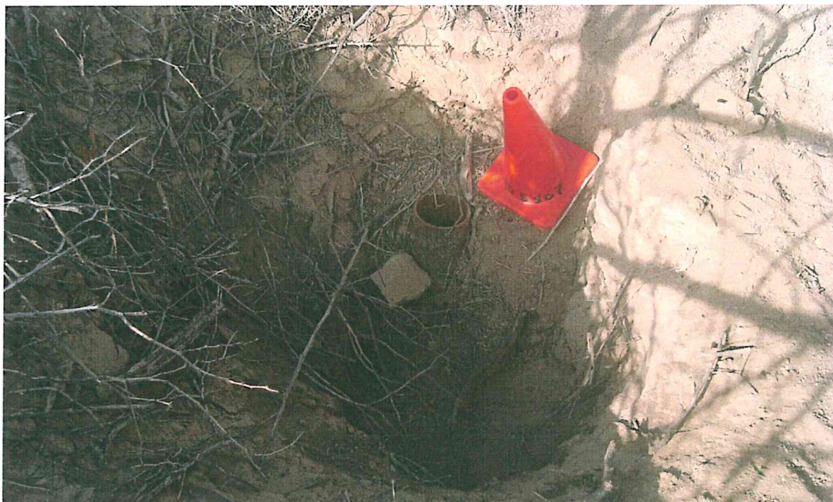
Fotografía N° 1. Pozo con código PERUPETRO T3851 y código Ficha OEFA F01787, se observa el casing del pozo corroído que no presenta ningún elemento de cierre por lo que se encuentra abierto al ambiente.
