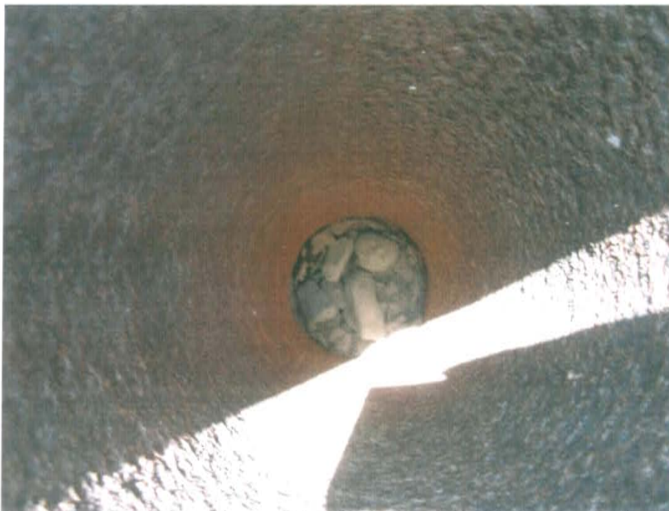
Fotografía N° 2. Se observa que al interior del Pozo T3244 se encuentra lleno de arena y piedras.
