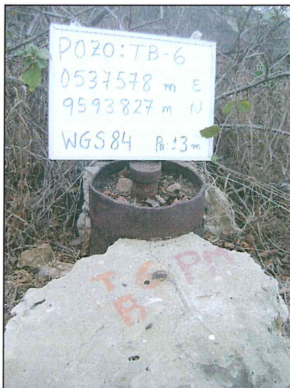
Fotografía N° 1.- Ubicación del Pozo TB-6 con código de ficha OEFA F00743, se aprecia relleno con materiales en su interior.
